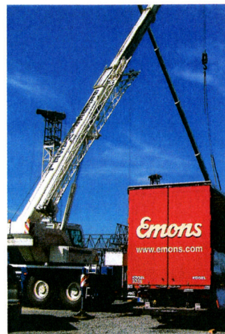
Emons-Lkw auf dem Baugelände.
